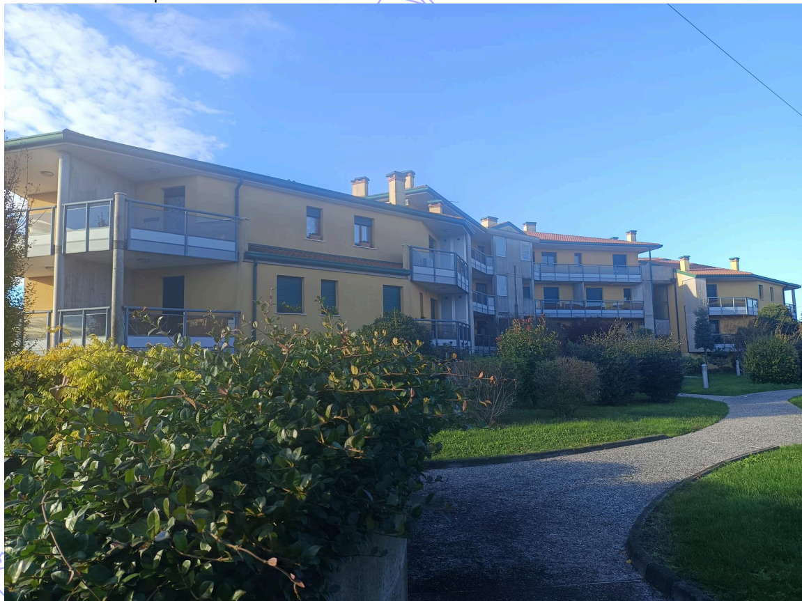
Vista edificio "Corpo A" dall'area comune
